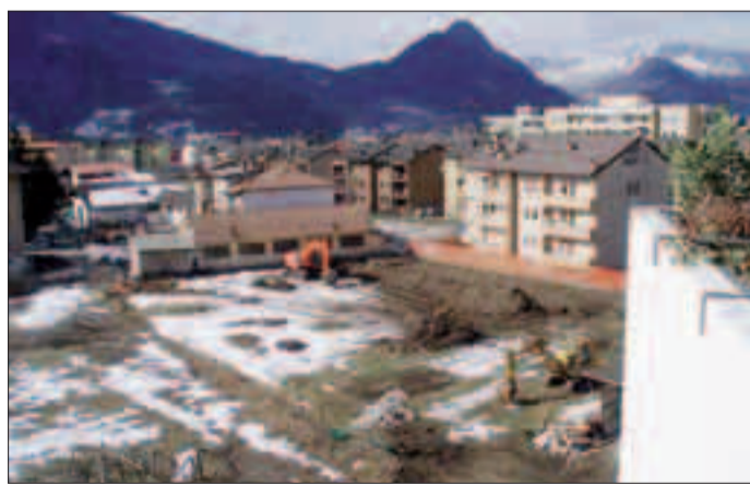
I lavori avviati sull'area «Giarete»
